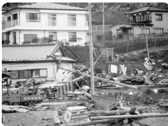
釜石市震災状況
